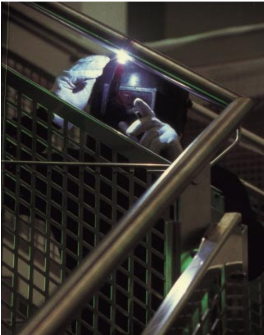
Bild 14: WIG-Schweißen auf der Baustelle
